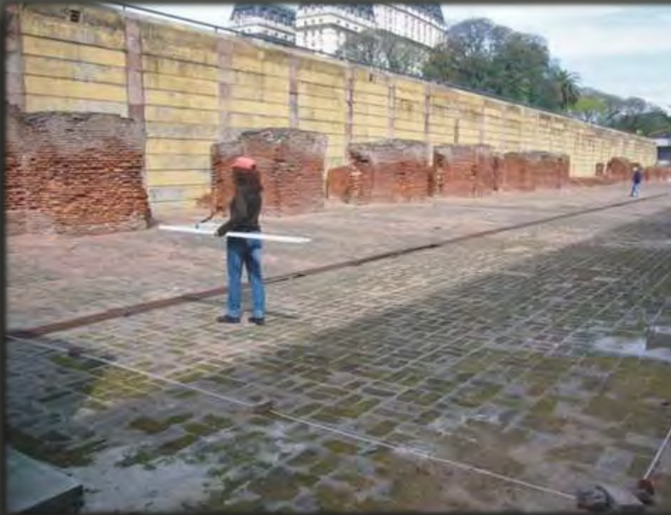
Prospección en la Aduana Taylor, durante los trabajos previos al emplazamiento del Museo del Bicentenario
